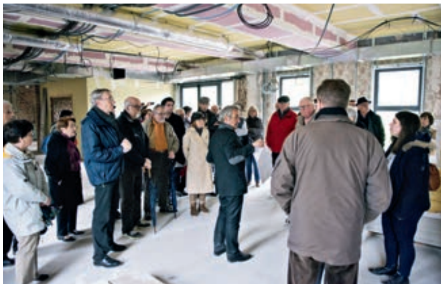
Visite du chantier du Domaine de la Mouline par les conseillers de quartier de La Mouline - Le Gô.
