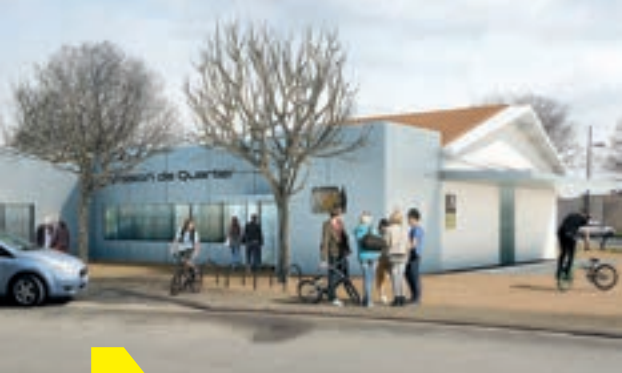
La maison de quartier du Rudel après extension et rénovation.
