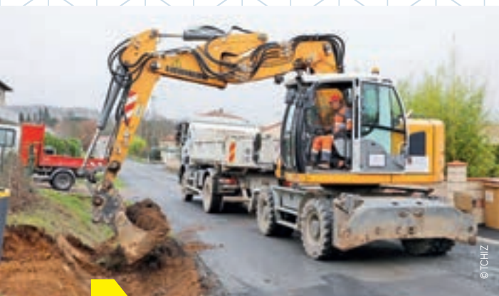
Poursuite de la mise en profil urbain de la rue du Marranel par la réalisation de travaux d'aménagement.
