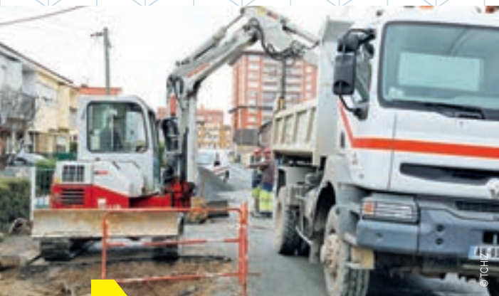
Travaux de voirie avenue Frédéric Mistral.
