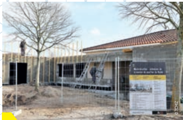
Extension de la maison de quartier du Rudel.
