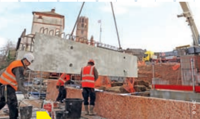
Construction de la passerelle piétonne et de ses abords.
