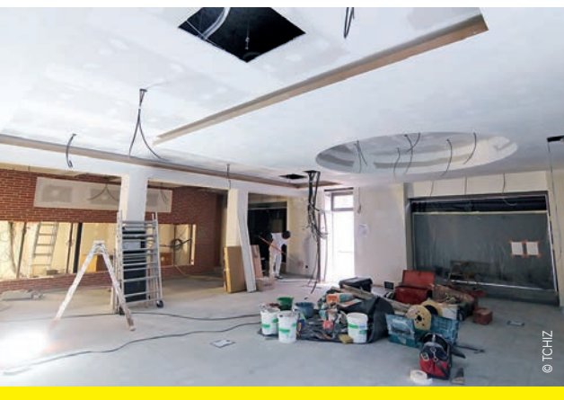
Chantier du futur office de tourisme, 42 rue Mariès, le 20 février
