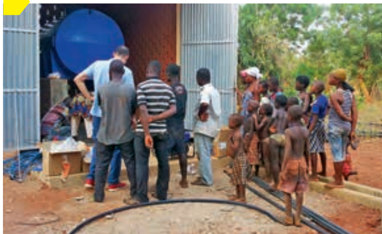
Le puits de captage d'eau potable financé par la ville d'Albi.
