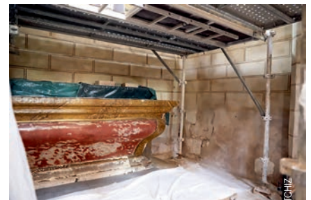
Chantier Chapelle Saint-Louis à la collégiale Saint-Salvi.
