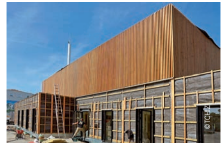
Police municipale, chantier de construction des nouveaux locaux à la Madeleine.
