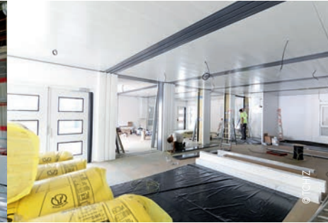
Travaux de rénovation à l'école de la Curveillère
