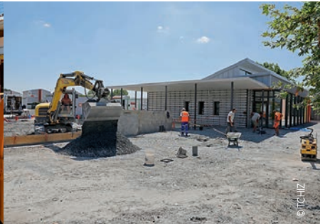
Construction du restaurant scolaire de la Viscose
