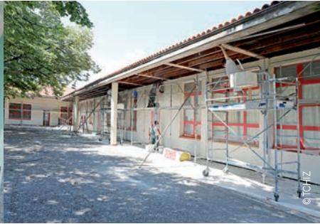
Travaux de rénovation à l'école Louisa Paulin Mazicou
