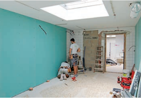
Travaux de rénovation à l'école Jean-Louis Fieu
