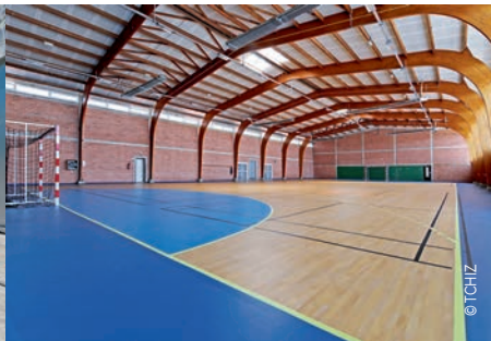
Rénovation du revêtement de sol au gymnase du Caussels
