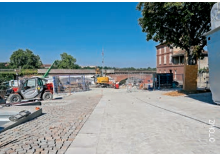
Aménagement de la Place du Château
