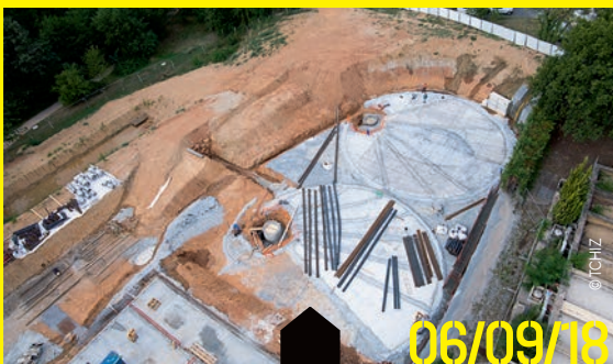
Démarrage des travaux de construction de la station de production d'eau potable, la Mouline
