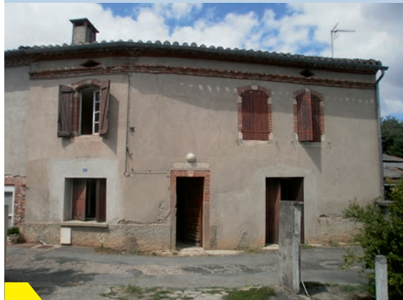
Bourdès avant travaux Soliha (2014)
