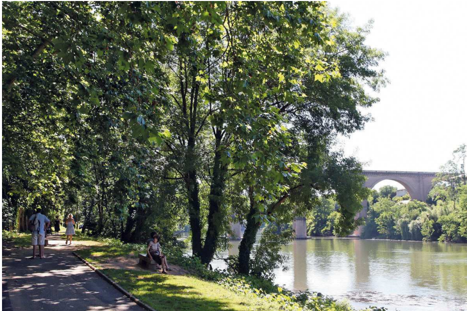
Consolidation et mise en valeur des Berges du Tarn
