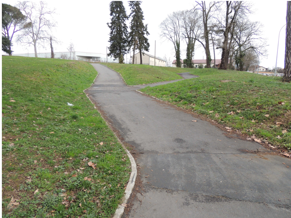
Aménagement de la liaison douce favorisant l'accès à la zone commerciale de Caussels.
