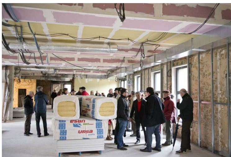
La salle de réception du deuxième niveau en cours d'aménagement
