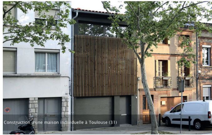
Construction d'une maison individuelle à Toulouse (31) Architecte - S.Deligny
