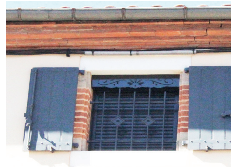
Mis en place d'un lambrequin pour cacher le coffret des volets-roulants, tout en préservant les volets extérieurs.
