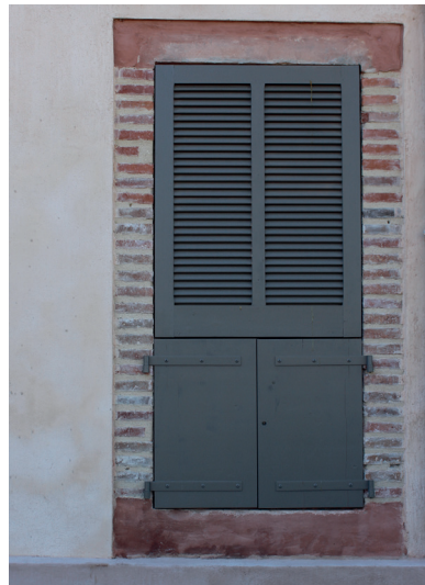
exemple de coffret technique intégré
