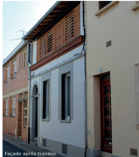
Façade après travaux
