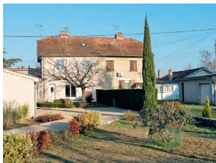
Maison ouvrière avec RDC+1, cité du Breuil © Mairie d'Albi
